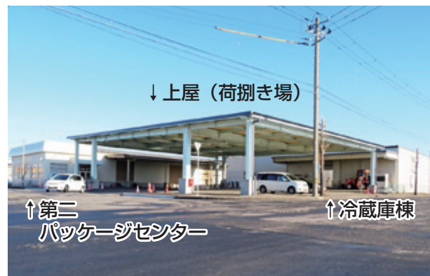
12月に竣工した上屋
